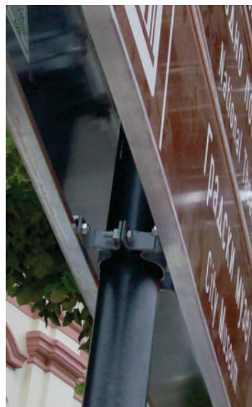
Aluminijumska šelna, za hvatanje na savijeni deo putokaza ili table
