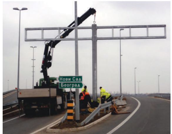
Proizvodnja i ugradnja poluportala
