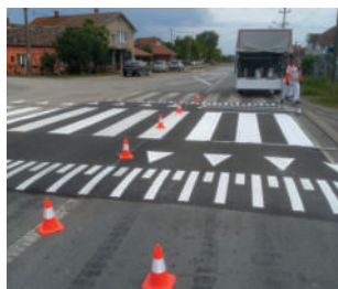
Platforma za pešački prelaz
