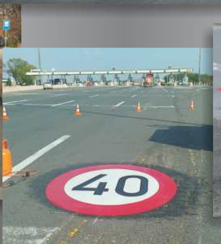
Postavljanje termoplastične oznake na asfalt
